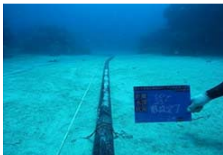
■ サンゴ礁帯を避けて砂地に敷設
