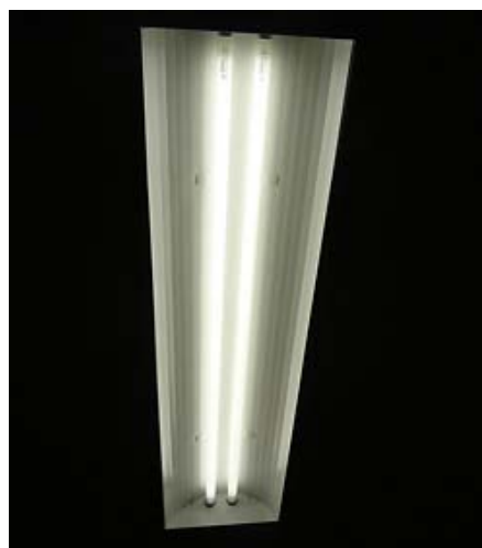
■反射板を設置した蛍光灯
