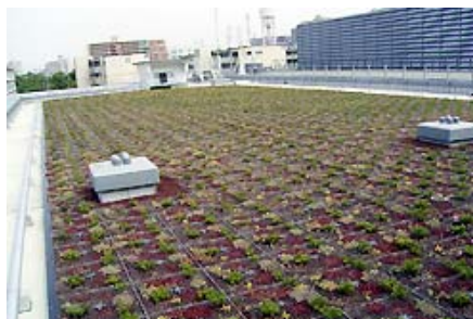
■東京都内の通信ビルの屋上緑化
