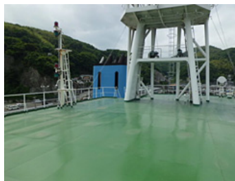
■ 遮熱塗料実施前
