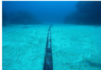
■ サング礁帯を避けて砂地に敷設
