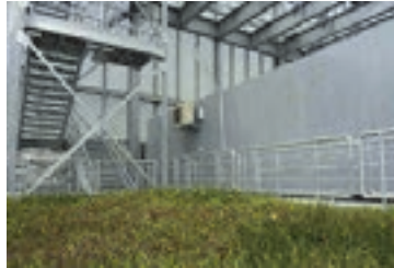
■シンガポールデータセンターの屋上緑化
