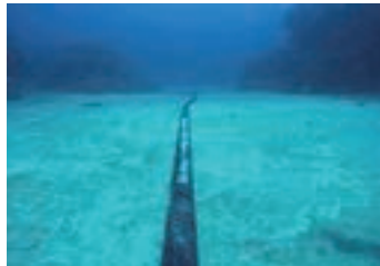
■ サンゴ礁帯を避けて砂地に敷設
