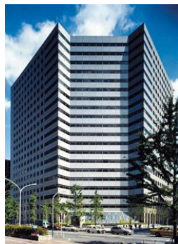
アーバンネット 大手町ビル
