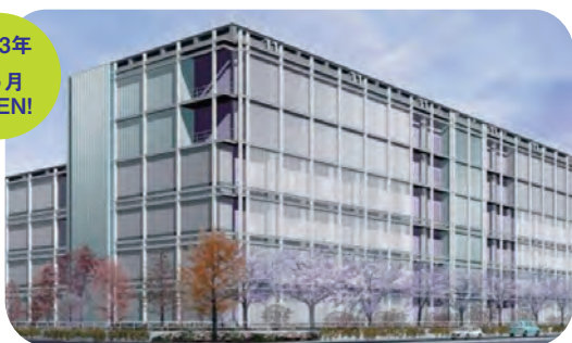
東京第6データセンター
